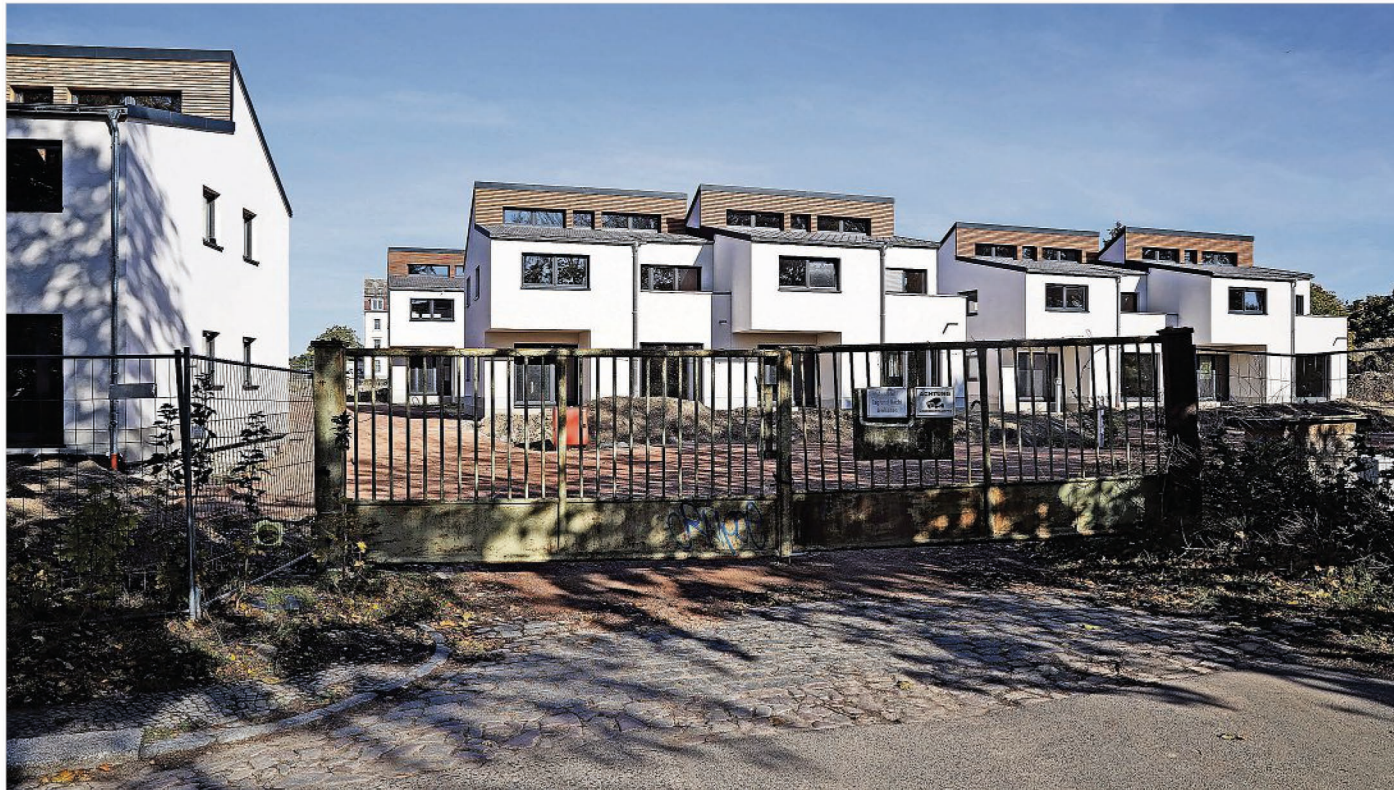
Äußerlich wirken die elf Häuser in der Brauerei-Siedlung zwischen Brauhausstraße/Heimweg und Poppitzer Straße in Riesa fertig. Sie sind es allerdings, wie die Siedlung insgesamt, bislang noch nicht.
