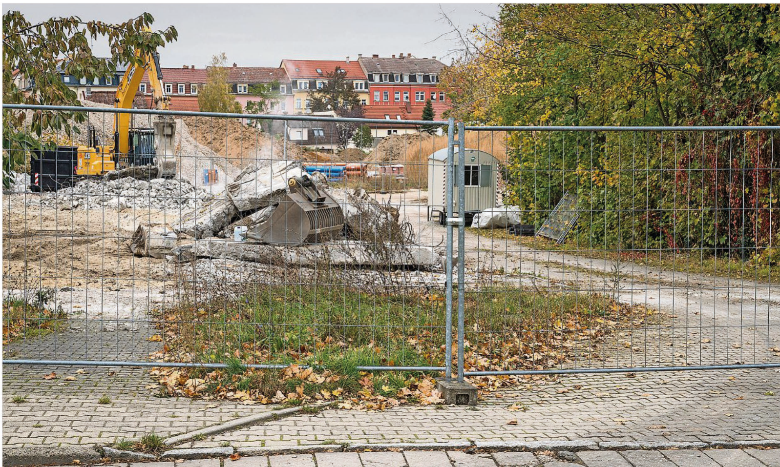
Seit mehreren Wochen laufen Abrissarbeiten am einstigen Lidl an der Stegerstraße. Nur ein Grundstück weiter wird die Brauhaussiedlung erschlossen. Anwohner spekulieren, dass beides nicht ohne Grund zur gleichen Zeit passiert.
