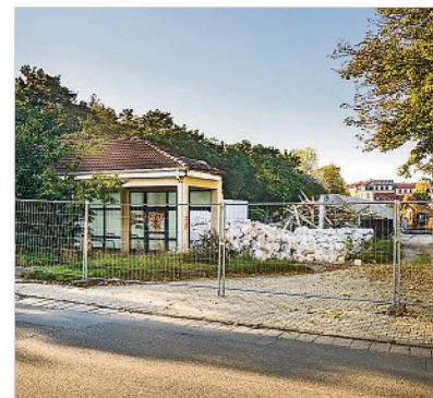
Schon kurz nach dem Start der Abrissarbeiten stand Mitte Oktober kaum noch etwas.
