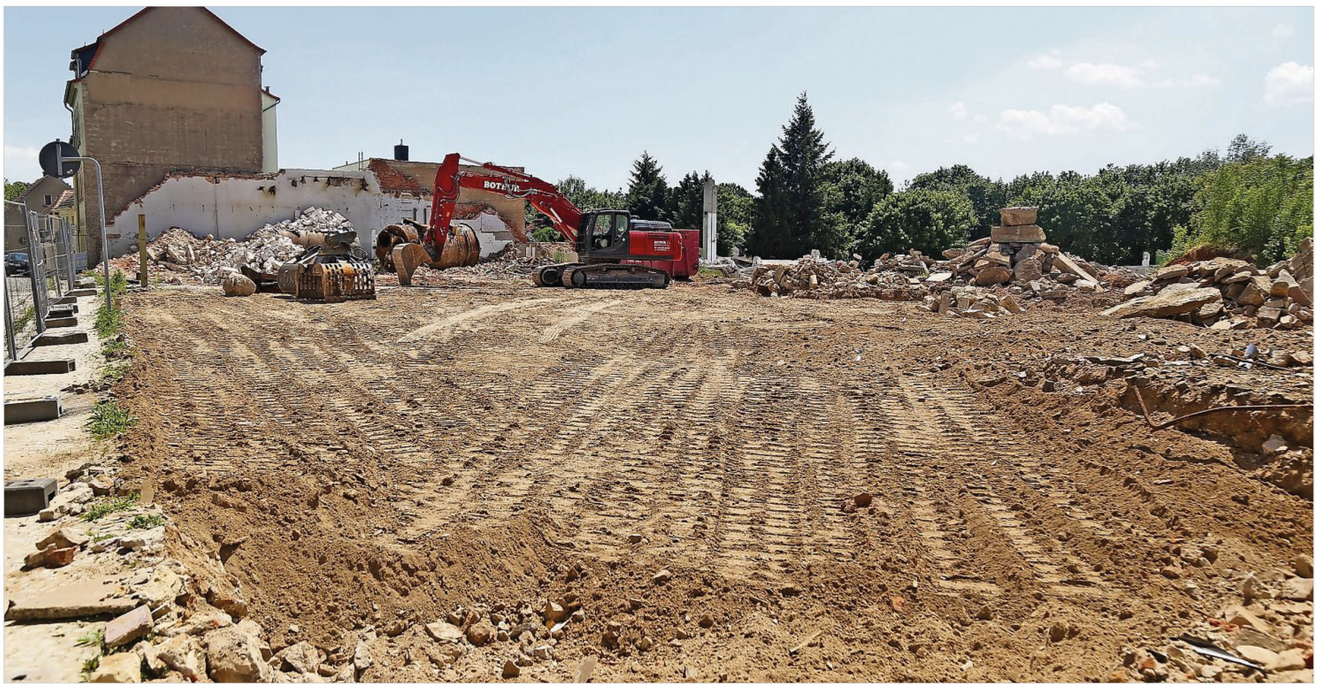
Die Freifläche auf dem Gelände der Brauerei – hier aus Richtung Poppitzer Straße fotografiert – wird immer größer. Bis Monatsende könnte die Fläche beräumt sein, hofft der Eigentümer. Foto: Sebastian Schultz
