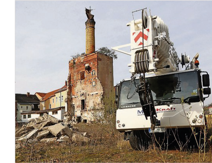
Auf dem Brauereigelände in Altriesa haben die Abrissarbeiten begonnen. Foto: Sebastian Schultz
